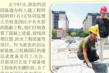
正午时分,浙农科创园基建的土建工程师陆明祥(右)正协同监理单位检查园区中央水景的隐蔽工程,他们仔细查看了混凝土质量、管线预埋位置、防水工程质量等项目。作为浙农的创业新基地,江虹路园区的建设进度备受员工关注。目前项目正处于准备竣工验收的关键阶段,为了确保新园区能在明年6月按期交付使用,项目团队在确保质量安全的前提下,牢牢把握每一个工程节点。
